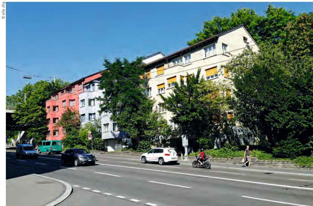
Rosengartenstrasse Diese Häuser werden für die zusätzlichen Fahrspuren abgerissen ...
